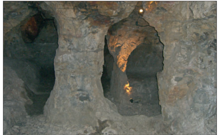
Blick in eine frühmittelalterliche Galerie, von der zahlreiche Stollen ausgingen. Um eine ausreichende Abstützung des Gesteins zu gewährleisten, wurden zwischen den einzelnen Gängen große Steinpfeiler stehen gelassen. Foto: KW.
