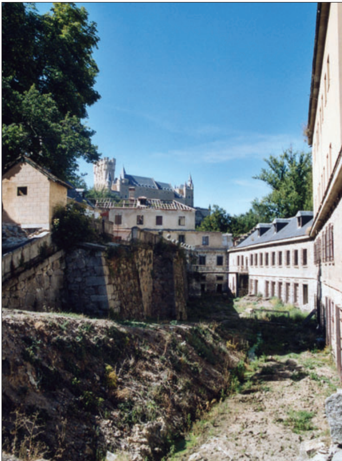
Ein Blick in den Innenhof der verfallenen Münzstätte vor ihrer Restaurierung. Vorne rechts das Gebäude, in dem sich einst das Walzprägwerk befand, dahinter die Unterkünfte für die Kaufleute, die ihr Silber und Gold nach Segovia brachten, um es dort ausmünzen zu lassen, ganz hinten das Gefängnis für Münzbeamte, die sich am Reichtum des Königs vergangen hatten. Foto: UK.
